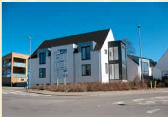
Passivhus på Vendelbogade, privatbolig i Hjørring
