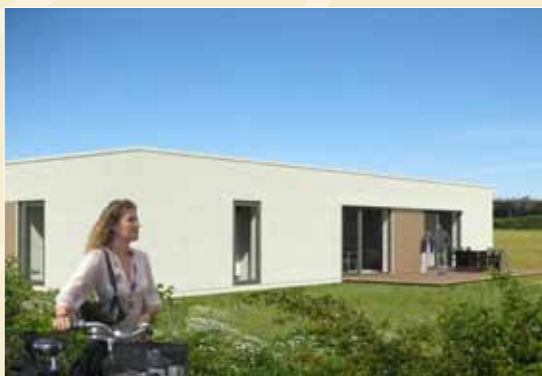
Passivhus på Grønnevang, privatbolig i Hjørring. Danmarks billigste passivhus. Færdigt i april 2011
