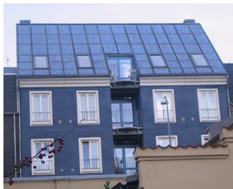
Solceller på taget af en etageejendom i Tøjhushavekvarteret
