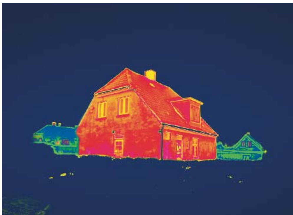
Termografering af et hus viser, hvor der er behov for tætning og efterisolering.
